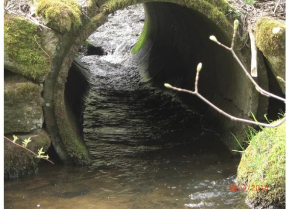
glatte Betonsohle und niedriger Wasserstand behindern die Durchgängigkeit
