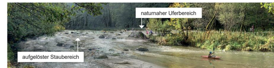
Abb. 4 Geplanter Zustand mit Blick flussaufwärts. Durchgängigkeit für Fische und anderen Wasserorganismen sowie Durchfahrtsmöglichkeit für Kanufahrer. Die schnellen Strömungsverhältnisse erstrecken sich noch ca. 900 m flussaufwärts.
