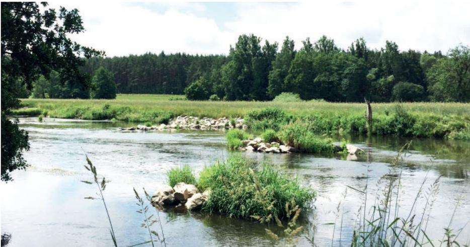
▲ Abb. 6: Struktureinbauten, wie Bühnen, Störsteine und Inseln zur Schaffung einer Strömungsvielfalt (Quelle: WWA Weiden)
