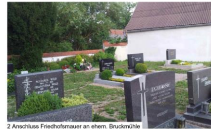
2 Anschluss Friedhofsmauer an ehem. Bruckmühle
