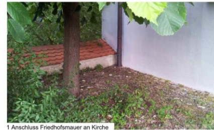
1 Anschluss Friedhofsmauer an Kirche
