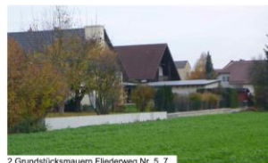
2 Grundstücksmauern Fliederweg Nr. 5, 7
