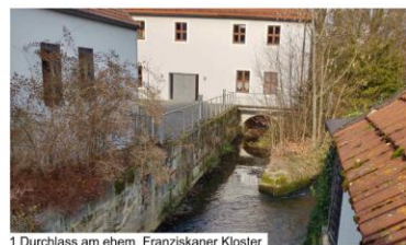
1 Durchlass am ehem. Franziskaner Kloster
