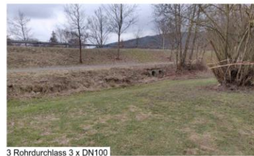
3 Rohrdurchlass 3 x DN100
