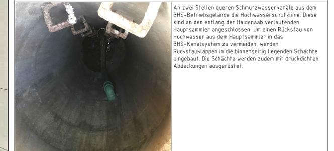
An zwei Stellen queren Schmutzwasserkanäle aus dem BHS-Betriebsgelände die Hochwasserschutzlinie. Diese sind an den entlang der Haidenaab verlaufenden Hauptsammler angeschlossen. Um einen Rückstau von Hochwasser aus dem Hauptsammler in das BHS-Kanalsystem zu vermeiden, werden Rückstauklappen in die binnenseitig liegenden Schächte eingebaut. Die Schächte werden zudem mit druckdichten Abdeckungen ausgerüstet.
