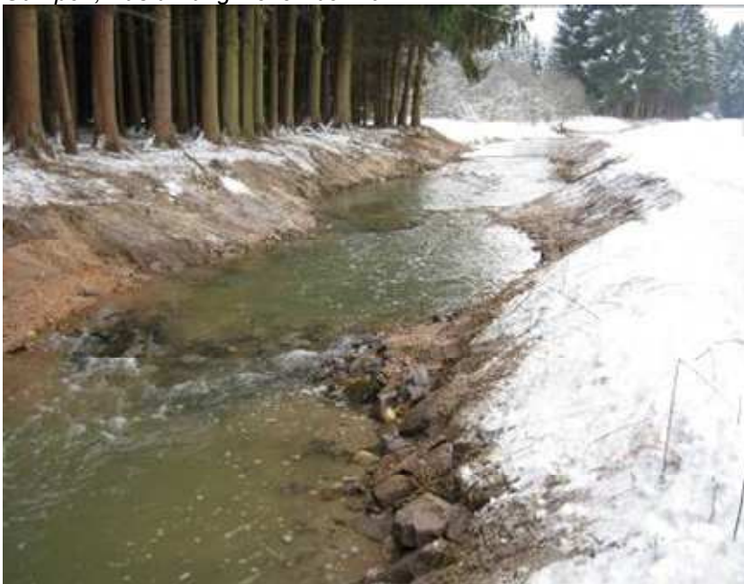
Foto: Ehenbach oberhalb Grünau, Umbau der vorhandenen alten Sohlbefestigung in Engstellen und Gumpen, Ausführung Dezember 2012
